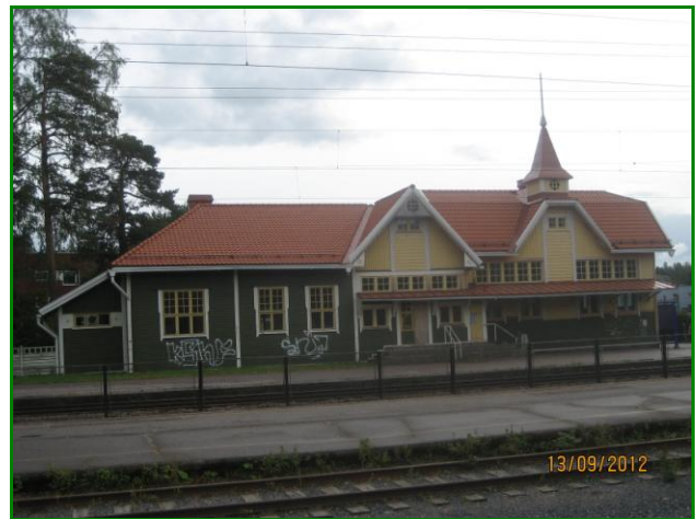
Palon jälkeen juuri kunnostettu kaunis asemarakennus, tyhjiällä ja nyt jo rappeutumassa
