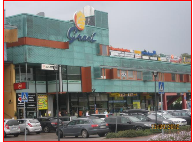
Kauppakeskus Grani 2001; likainen ja pahasti rapistuva julkisivu jo nyt 10 vuoden jälkeen
