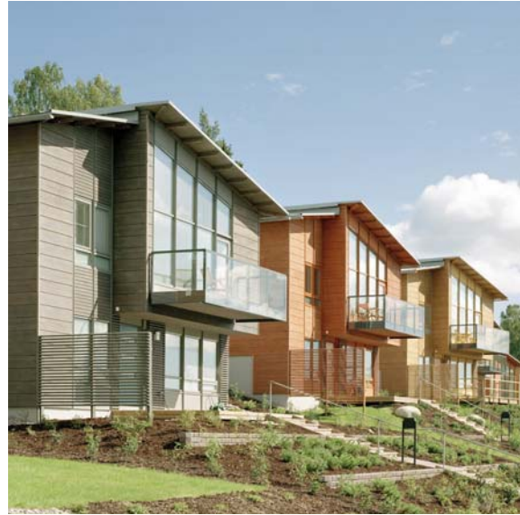
Modernia pientalorakentamista Espoon Friisilässä. Yhteistyökumppaneina Espoon kaupunki, Finnforest Oyj ja Skanska Talonrakennus Oy.
